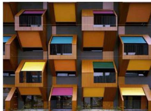
Ofis arhitekti, **Honeycomb Apartments**. La caratteristica evidente dell'intervento è proprio la dotazione, per ogni unità, di un'estensione esterna costituita da uno spazio di loggia solare/buffer space, protetto dalla radiazione solare diretta e assicurante un buon livello di privacy. Ogni loggia è una struttura metallica indipendente e autoportante appesa al fronte, che fornisce uno spazio esterno, privato, completamente fruibile e integrato con l'alloggio
